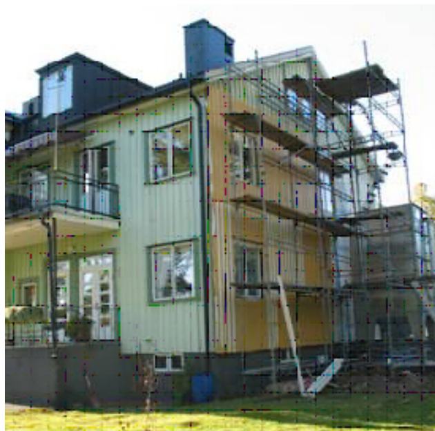
Folkets hus i Gunnebo. På gaveln har tilläggsisolering och fönsterbyten påbörjats. I kulturminnesvårdsprogrammet för Västerviks kommun är Gunnebo framlyft som ett värdefullt karaktärsområde och Folkets hus angivet som en av värdebärarna. Boverket beviljade föreningen 2005 "Stöd till samlingslokal" för olika energieffektiviseringsåtgärder. Delar av åtgärderna bedömdes av länsmuseet medföra en förvanskning av en särskilt värdefull byggnad.
